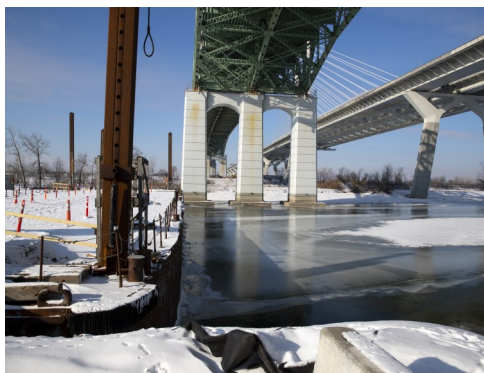
Pile 1E entourée d'une jetée en vue de la déconstruction de la travée en porte-à faux Est
